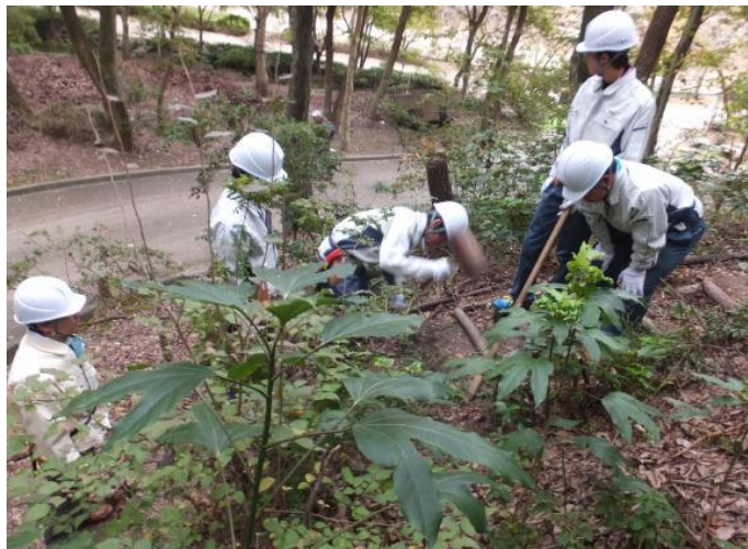
散策路の修復作業(その1)
