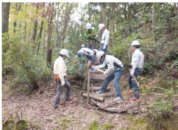
散策路の修復作業(その2)
