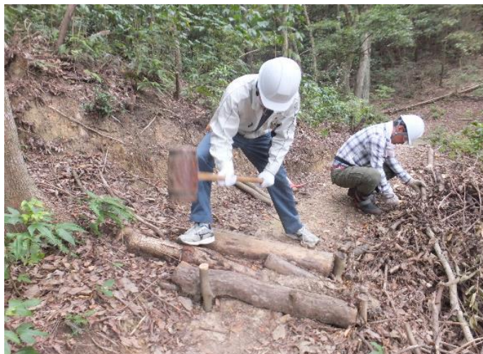
遊歩道の修復作業
