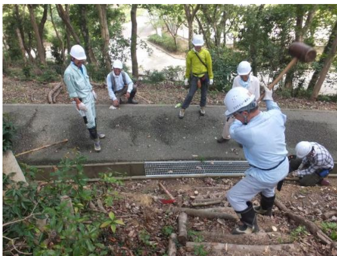
散策路の階段修復作業
