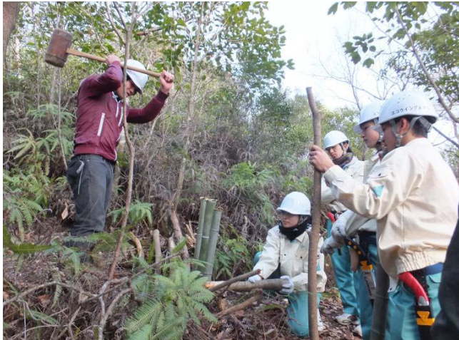
立ち入り禁止の柵の補強作業
