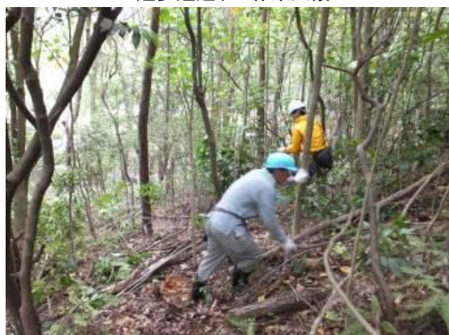
遊歩道造りの作業風景
