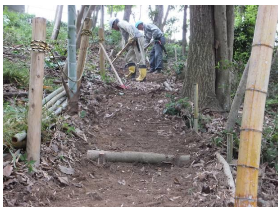
遊歩道作りの作業風景
