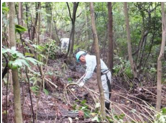
遊歩道作りの三期工事
