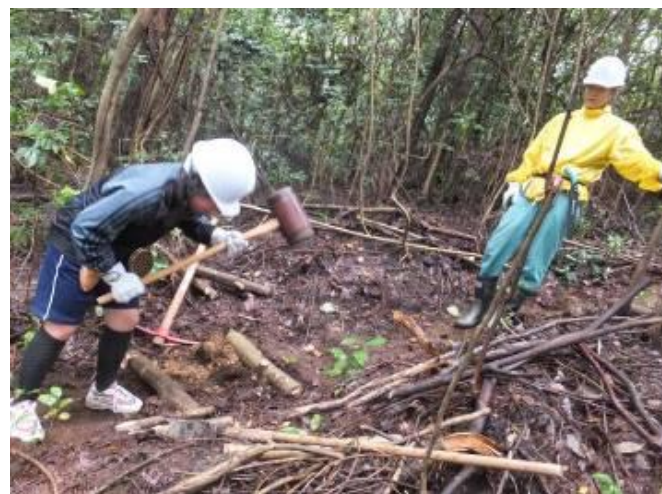
遊歩道の階段作り
